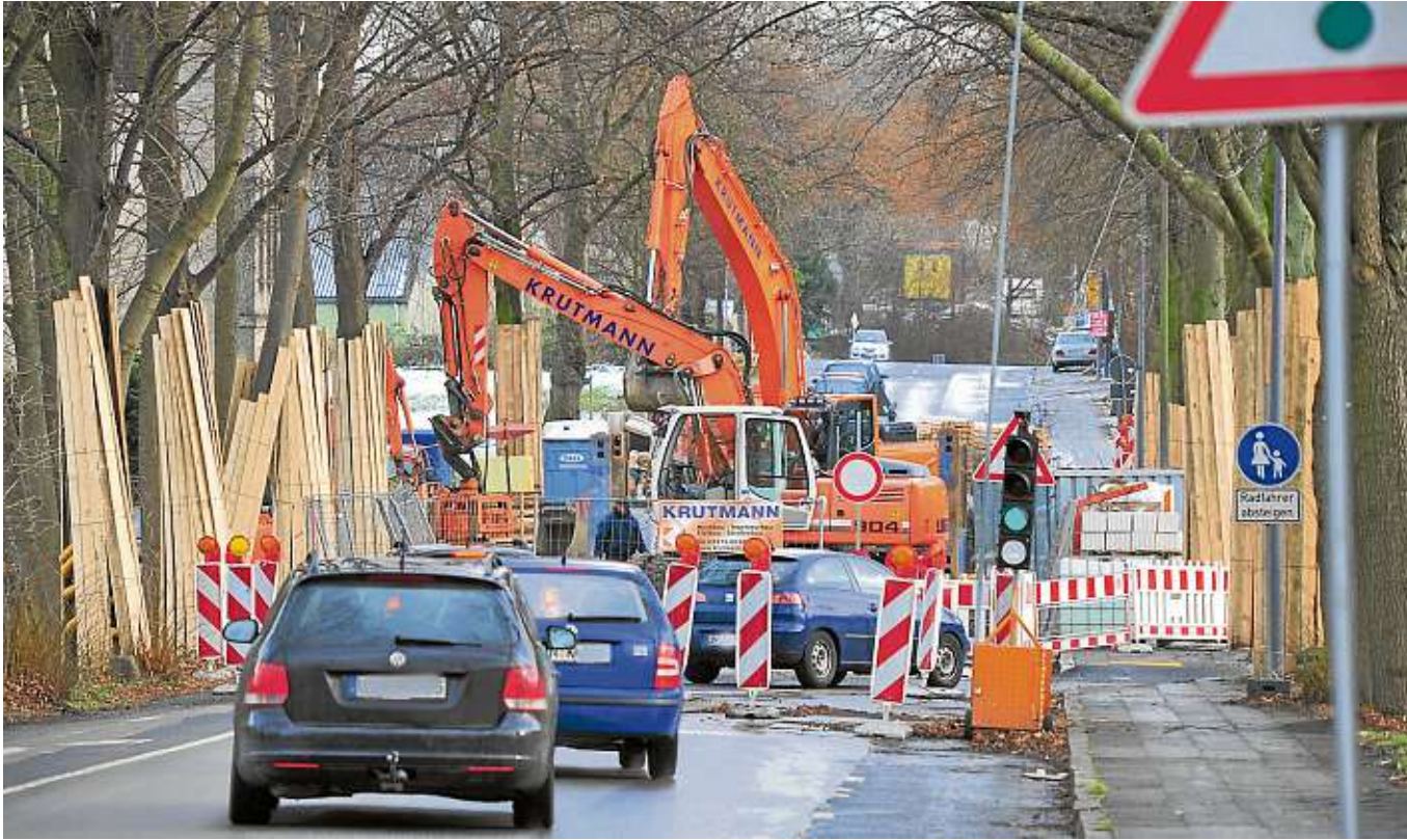
Der Rohrdurchlass des Höinger Baches durch die Morgenstraße ist in der kommenden Woche fertig. Im kommenden Jahr soll die Straße in diesem Bereich neu aufgebaut werden und endlich eine intakte Fahrbahndecke erhalten. Zurzeit wird der Verkehr über eine Behelfsstraße an der Baustelle vorbei geleitet – endlich rumpelfrei! Foto: Grzelak
